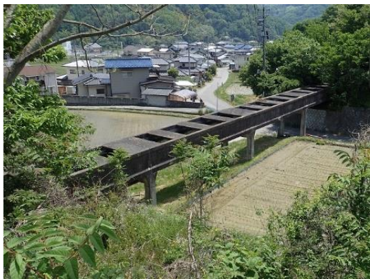
松葉沢水路橋
