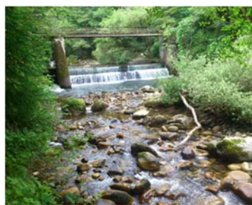
烏川からの取水
