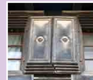
旧若松屋の建具は、開き扉の召し合わせ(重なる部分)が段形で密閉性を高める構造となっています。
